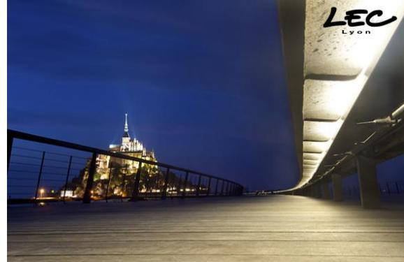
LEC a fabriqué 430 mètres de barreaux 5620-Brunei soit 296 barreaux sur-mesure d'1,45 mètres, qui sont intégrés sous le linéaire de séparation des 2 voies reliant le Mont Saint-Michel au continent.
