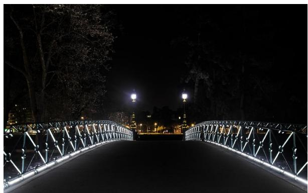
Le garde-corps est éclairé avec deux lignes de 22 m de linéaire 5620-Brunei, , avec 160 diodes par mètre, en blanc 4000°K le long du pont de chaque côté soit 44 m.
