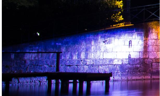
Les flancs des rampes d'accès sont éclairés par 4 projecteurs 4040-Luminy 4 en RGBW, optique 20°
