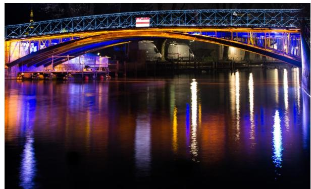
La sous face du pont est mise en lumière avec 12 projecteurs linéaires 5633-Arches en ambre et sa partie centrale est éclairée par 6 projecteurs 5633-Arches en bleu. Différentes optiques sont utilisées.
