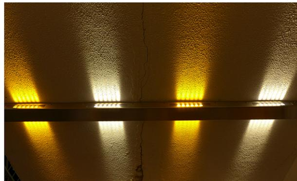
Pour cette réalisation, 80 linéaires à LED 5633-Arches à optique L4, dont 40 en blanc chaud et 40 en ambre, éclairent le passage par alternance de bandes lumineuses de couleur. Des caissons inox, fabriqués sur-mesure, protègent du vandalisme éventuel les linéaires à LED et l'ensemble du matériel électrique et électronique (alimentations, drivers, connexions, câbles).
