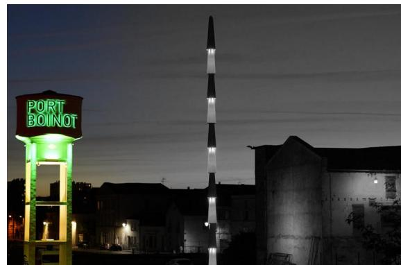
Des barreaux LIMA (5680) avec optique de 10° en blanc chaud 2700K et en vert mettent en lumière le château d'eau. Les barreaux et leurs pattes de fixation sont peints dans une couleur spécifique qui leur permettent de se fondre dans le paysage en pleine journée. Les barreaux sont pilotables en DALI.
