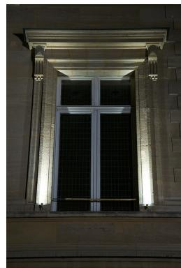
48x 4010-CE-10 Luminy pour éclairer les 24 fenêtres du 1er étage, soit 2 projecteurs par fenêtre installés de chaque côté.
