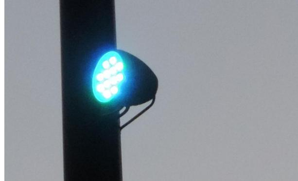
Fixés sur des mâts, 6 projecteurs 4040-Luminy 4 de 12 LEDs (5 en vertes, 7 en bleues) à optiques quasi-dédiées à chaque emplacement (10°, 20°, 36° et 52°) éclairent 3 faces du bâtiment.
