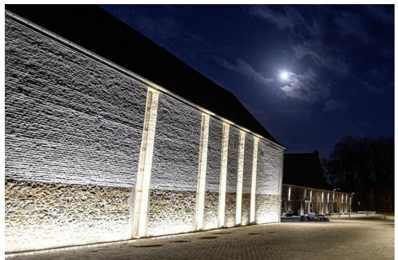
19 mètres de barreau Brunei (5620), équipés de LED de type Z et d'optique 45° éclairent un blanc neutre la grande façade du bâtiment. Les 5 alcôves toutes en hauteur sont soulignées par des projecteurs Allevard (5716)
