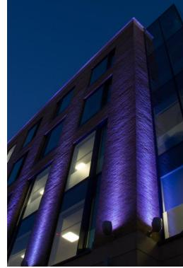
Les 11 projecteurs 4060-Luminy 6 sont orientables et étanches, équipés de 36 LED à optique 10°, et sont installés au premier niveau de la façade.
